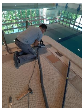
Vorbereitungsarbeiten Für Plättliboden
